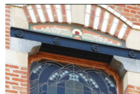
linteau en acier apparent
