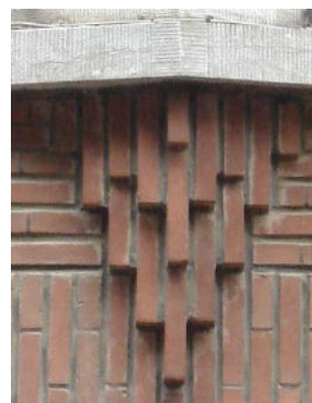
appareillage de briques
