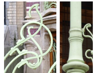
▲ fer forgé colonnnette en fonte ▲
