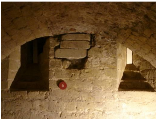
Fenêtres en partie couvertes par une voûte ©CDP
