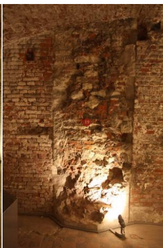
Intérieur d'un pilier ©M. Vanhulst.
