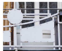
Garde-corps en tôle découpée et fer forgé : quelques fines lignes encadrent des formes pleines dont l'arrondi répond à celui du motif sous la corniche
