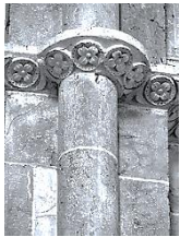
colonne engagée (dans un mur)
