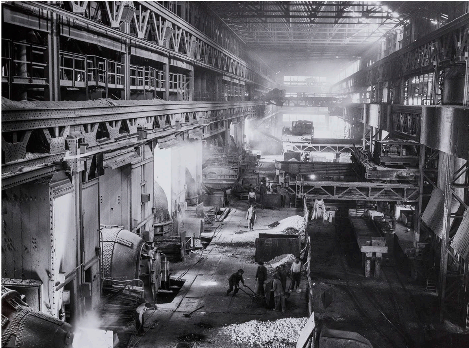
Une usine avec sa structure de poutrelles métalliques
