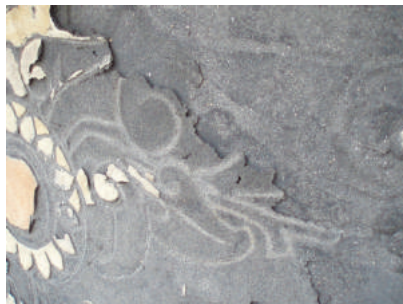
Problème de cohésion et d'adhésion entre les couches avec perte de matière
