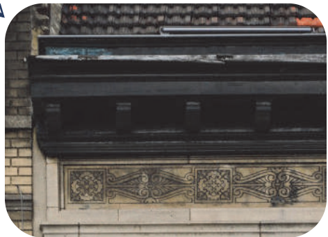
Frise de sgraffite sous la corniche
