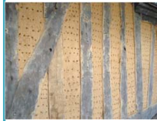
pans de bois (structure de poutres)
