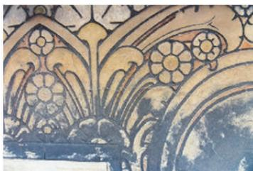
*Érosion de l'enduit de surface due aux intempéries*
