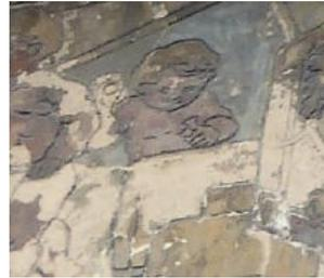
Un **mauvais entretien de la corniche** accélère la dégradation du sgraffite. L'eau **s'infiltre** dans l'enduit. Quand il gèle, le volume de l'eau augmente et provoque la désolidarisation entre les couches d'enduits ou des crevasses.
