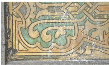
L'enduit a été mouillé de manière excessive, le jet de sable a détérioré le sgraffite le long du bord gauche et il reste du sable sur l'ensemble de la surface.
