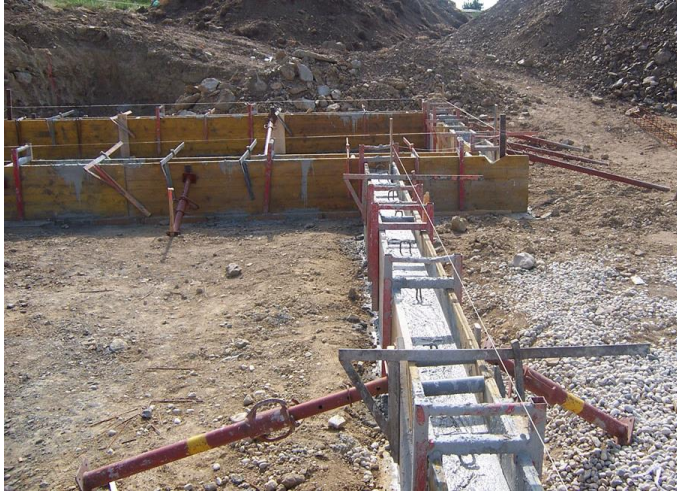
Béton coffré
