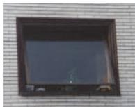
Le **châssis basculant** (sur un axe horizontal) ou **pivotant** (sur un axe vertical) est à la mode.
