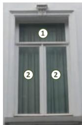
Grande fenêtre à **imposte fixe ①** et à **double ouvrant ②**, souvent protégée au rez-de-chaussée par des contrevents (volets extérieurs) en bois.
