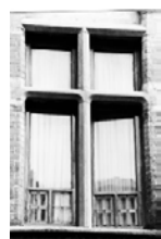
fenêtre à croisée
