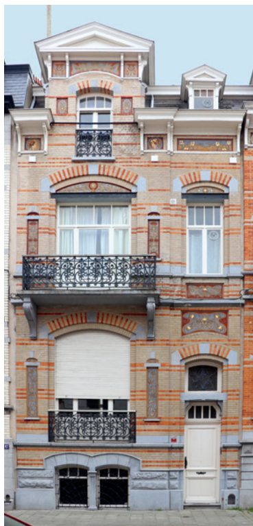
Jennevalstraat 15, Brussel Uitbreiding Oost, arch. Josse Van Krieking, 1902
