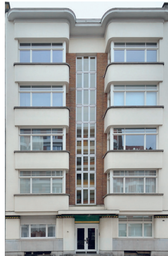
Cervantesstraat 75, Vorst, arch. René Delbecq, 1934
