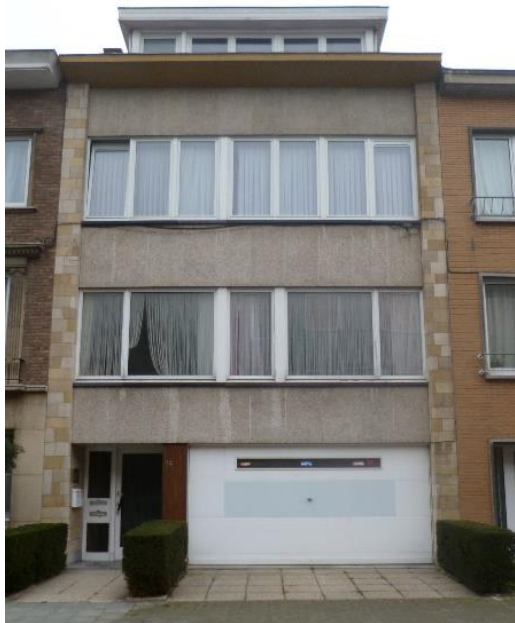
Jette, rue Firmin Lecharlier
