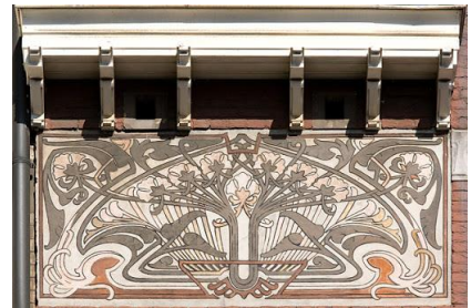
Sous la corniche
