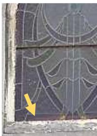
Châssis et mastic en mauvais état
